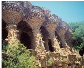
▲碎石高架走廊
